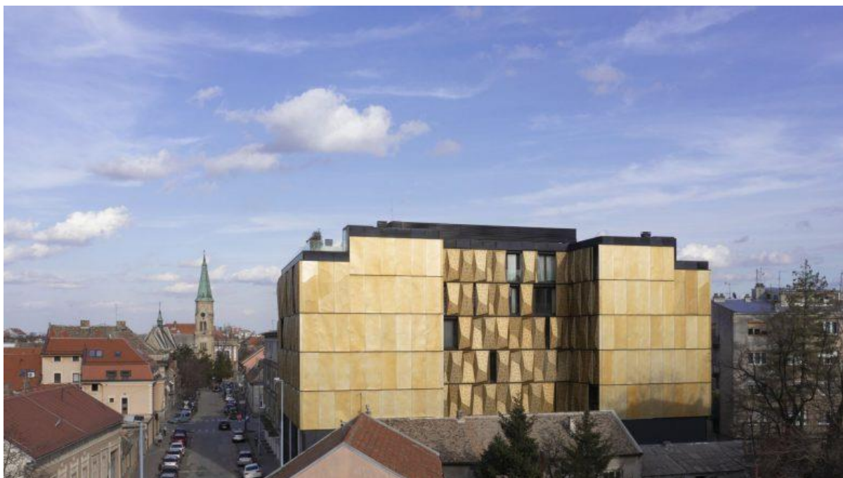
Zgrada SK12 u Pančevu realizovana je 2020. godine; Foto: Danilo Dangubic Architects
