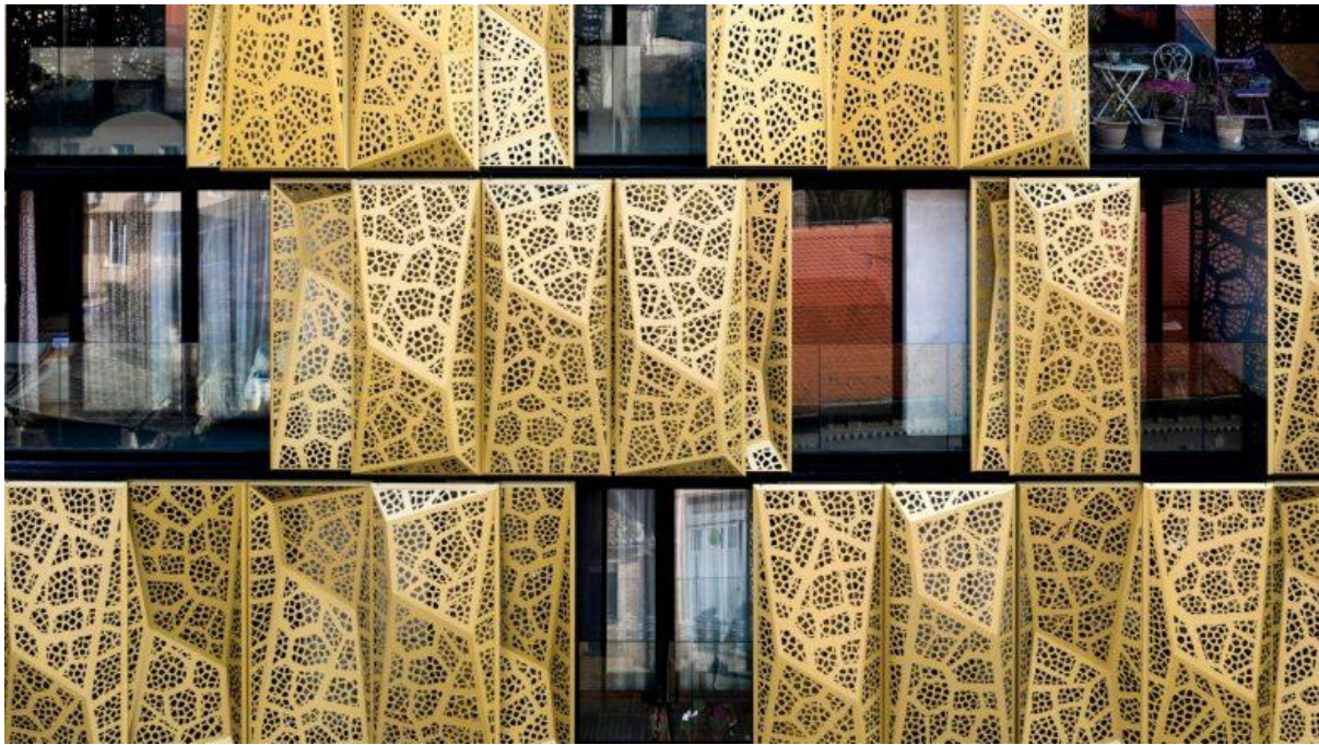
Fasada zgrade SK12 u Pančevu; Foto: Danilo Dangubic Architects
